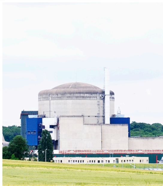
Fig. 4.2 / Une enceinte de confinement vue de l'extérieur.
